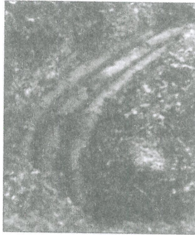
شکل ۱-۱۱ قطعات خط لوله پرگامون - قطر هر لوله سفالی بین ۱۳ تا ۱۸ سانتی متر بود.
